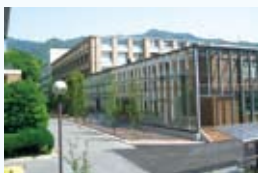
改修された工学研究科本館
