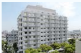
基礎学舎・北棟(耐震補強と改修の完成)
